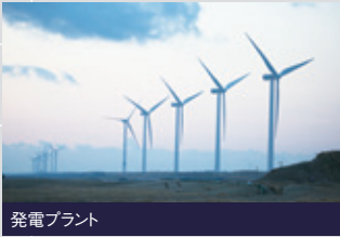
発電プラント
